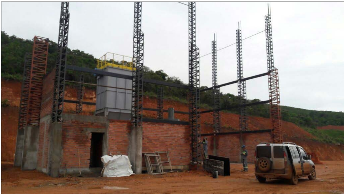
Infraestrutura do Moinho em implementação.
